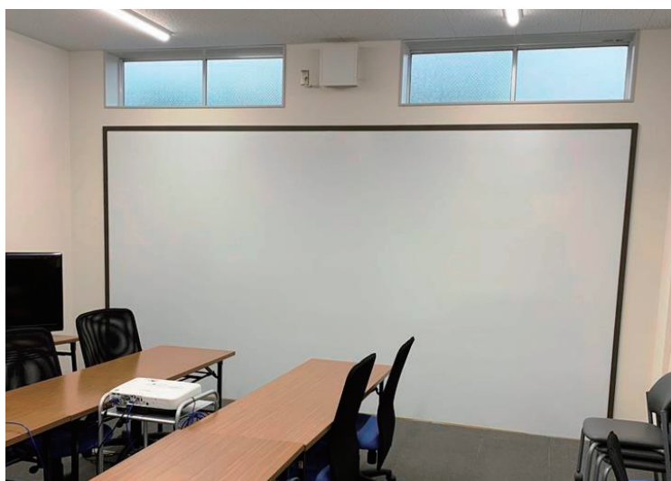
施工場所 縦2.4m×横4.5m 横貼り3段（2か所ジョイントあり）
