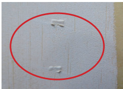
下パテ処理後 (上パテ時均す)
