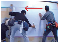
②エア抜き (内側から外側へ)
